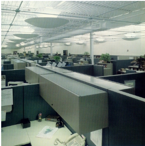
[그림 11] 사무가구 내장형 국부조명기구와 간접조명방식의 TAL
