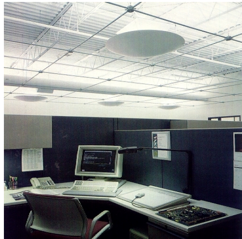
[그림 12] 탁상용 국부조명기구와 간접조명방식의 TAL
