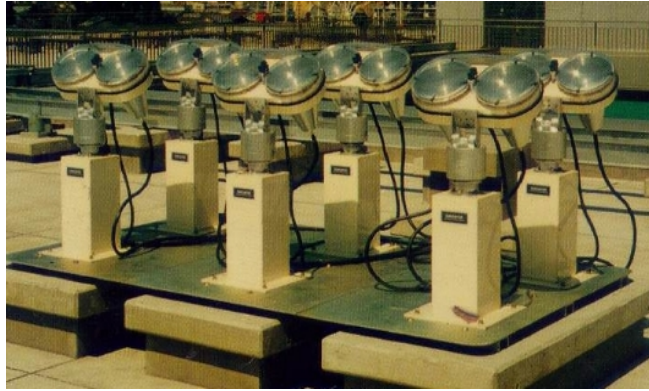
[그림 2.1.5] 광섬유를 이용하는 태양광 추적장치
